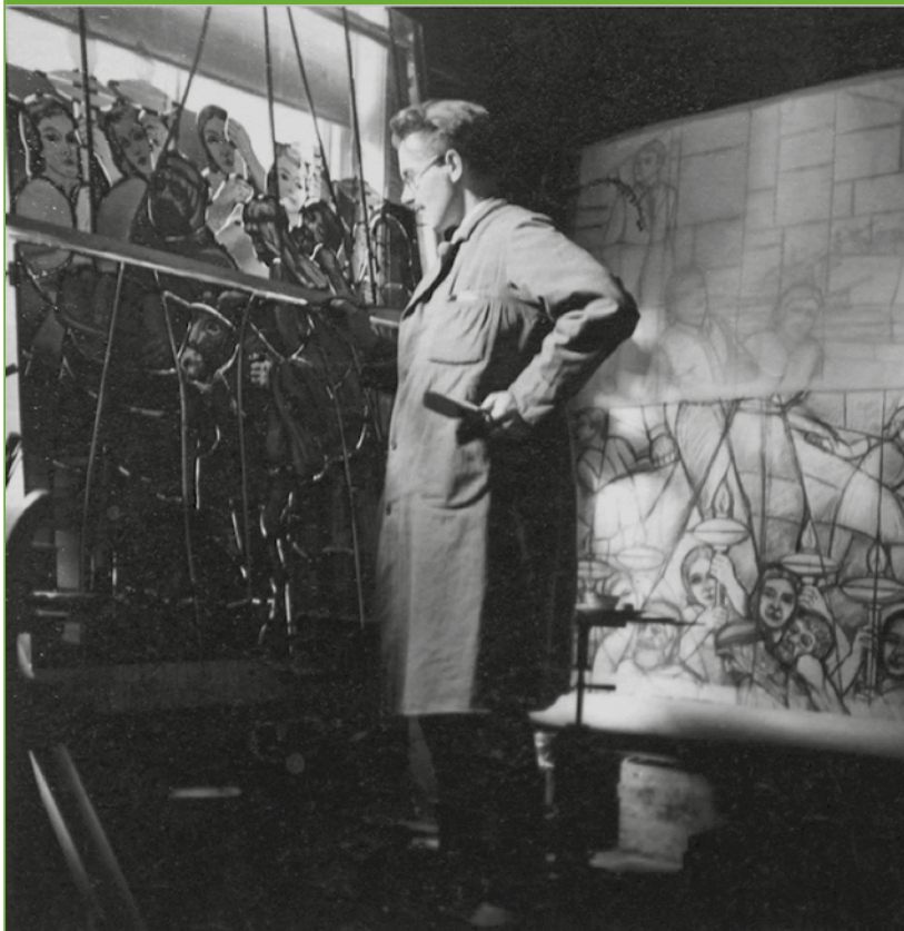
Het beschilderen van de opgetaste glasstukken tegen het schilderraam, door glazenier Hendrik Gerrit Bokhorst. Rechts op de wand hangt de werktekening.
